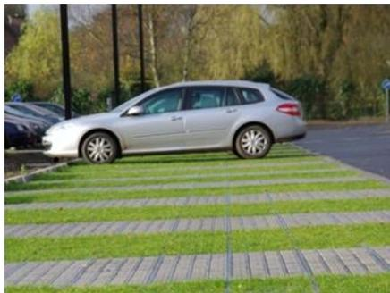
*avec des bandes béton pour la trace des roues*
