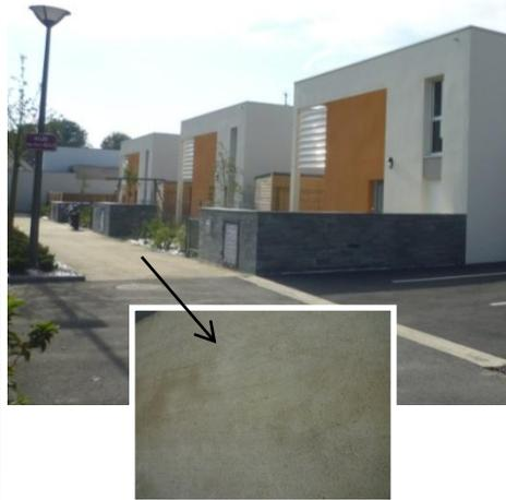
Sable stabilisé par un liant hydraulique
