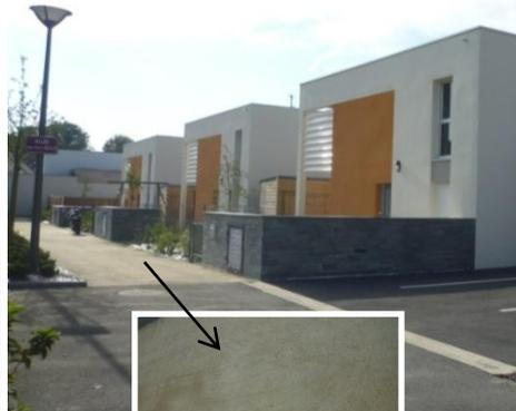
Sable stabilisé par un liant hydraulique
