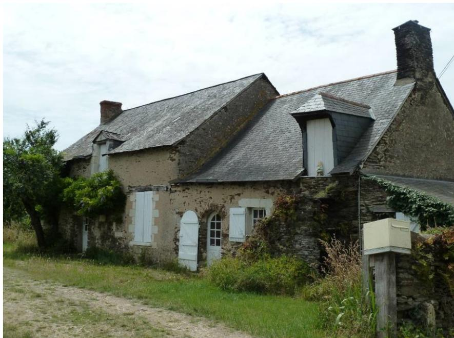
Les longères réhabilitées laissent apparaître la structure des murs par un enduit beurré de couleur assortie à la pierre qui compose le mur.
